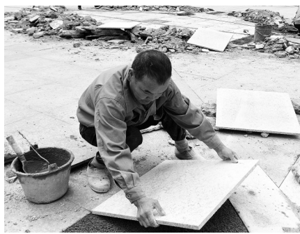
宝德路小区改造现场 吴纲兰摄
